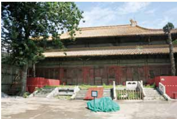
開始維修的大高玄殿。面闊七間，重檐黃瓦廡殿頂。姜鳴 2015 年攝
