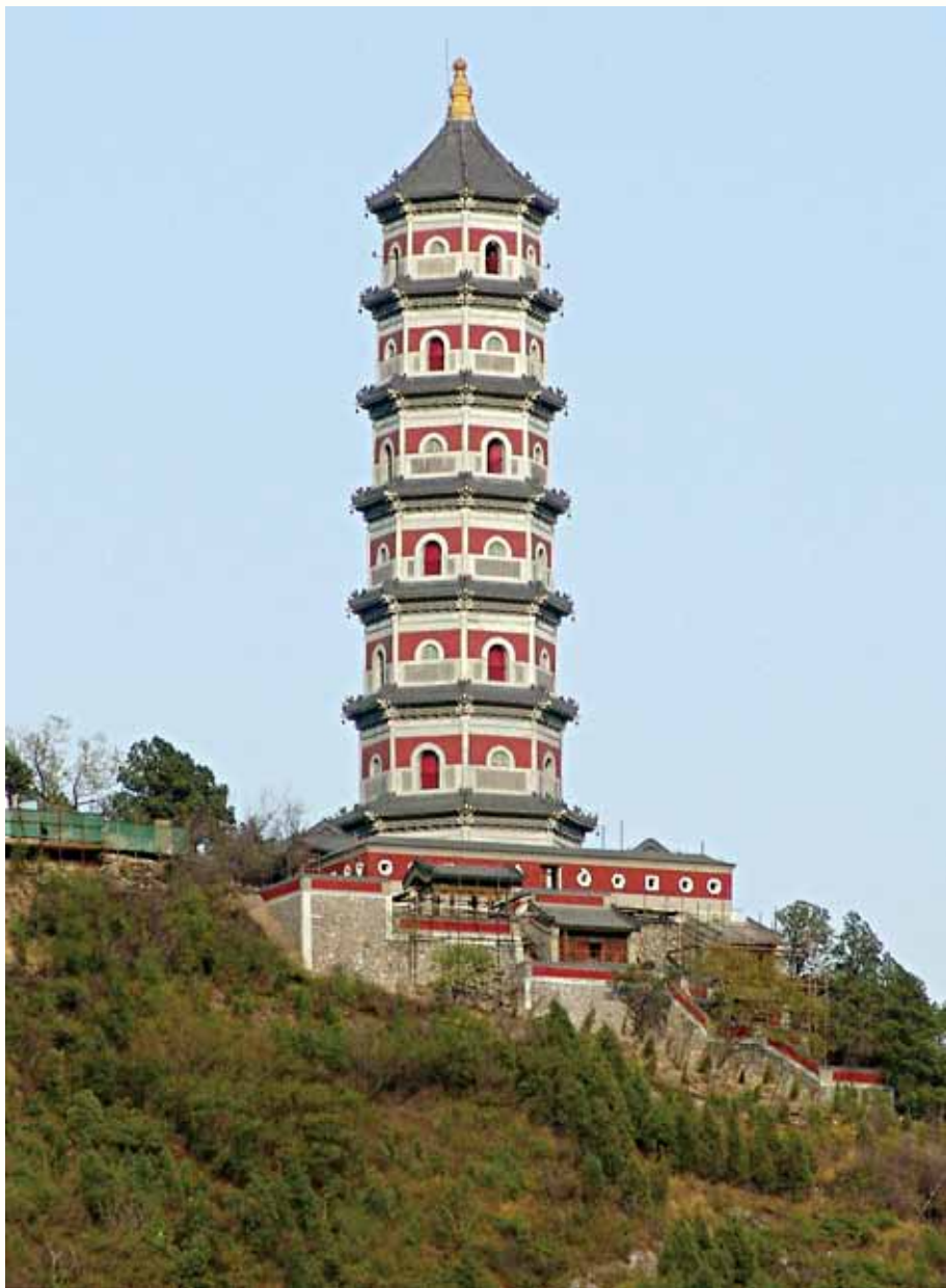
2005 年經過修繕後的玉泉山玉峰塔，恢復了紅色的塔身 姜鳴 2005 年攝
